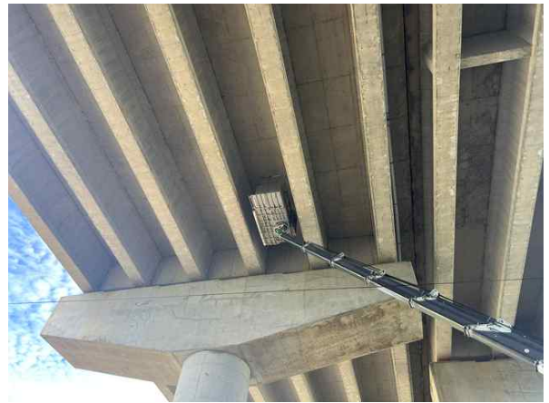
고소차를 이용한 근접조사
